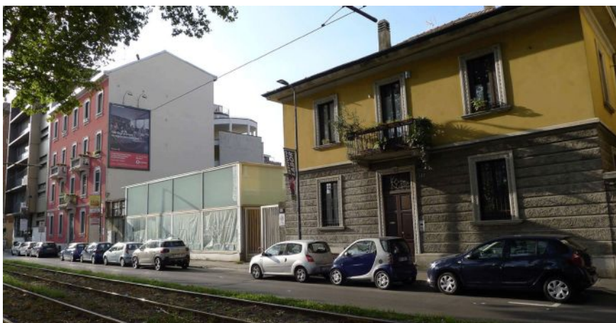
Viale Certosa. Lo stato antecedente l'intervento di riqualificazione (credits, Calzoni Architetti)
